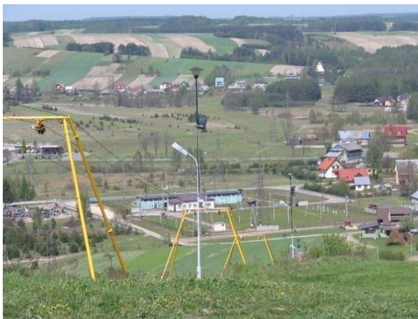
Ryc. 45. Rozdzielnia Sieniowa 15/15 kV przy ul. Spokojnej w Krasnobrodzie.
