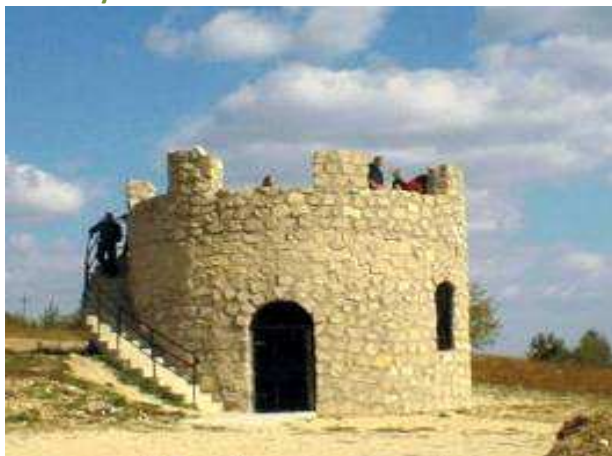
Ryc. 29. Wieża - punkt widokowy w Kamieniołomie
